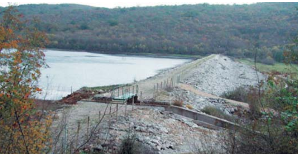
Pogled na branu koja odvaja akumulaciju Ponikve od ponorne zone
